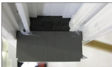
**Dib. 3** Fijar con silicona la pieza **M435** en el canal de herraje de la hoja
